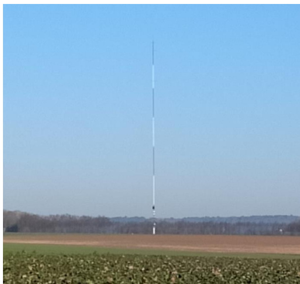
Figure 4 : Photographie du mât installé sur site
