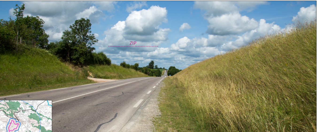
Photographie 4. Depuis la sortie nord d’Argentan (D958)
